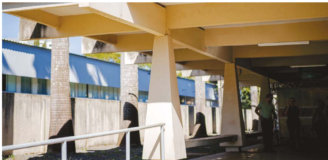
Obras de adaptação da antiga sede do Ipasgo, repassada pelo Governo de Goiás ao município, já começaram
