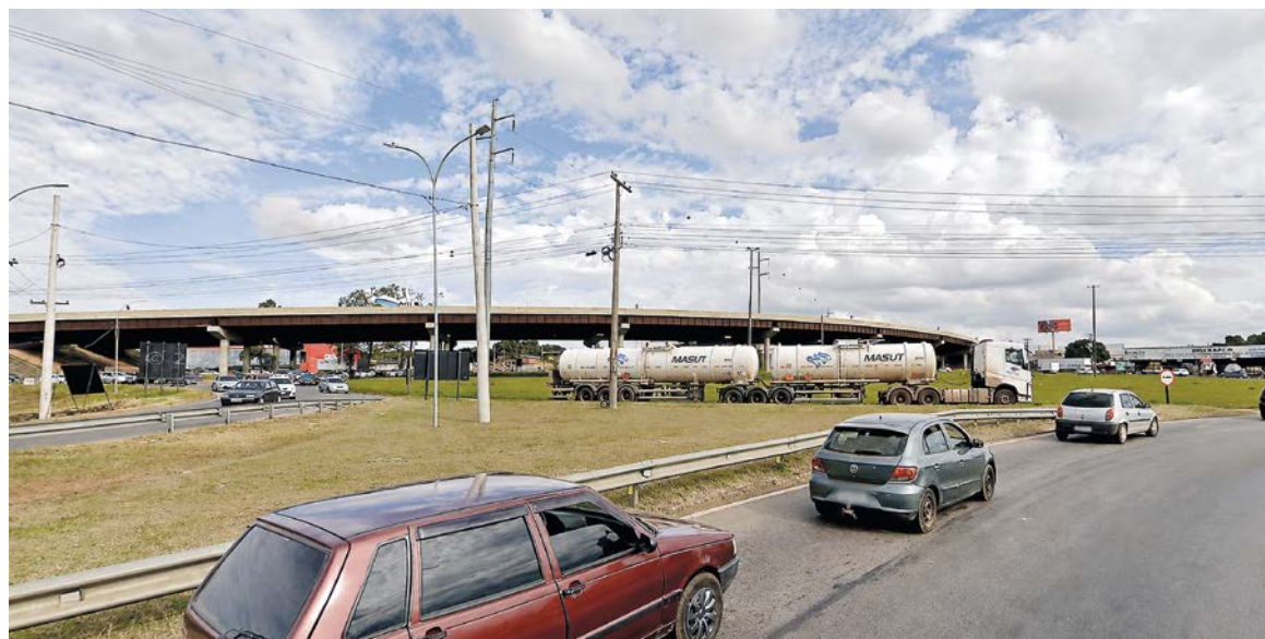
Viaduto Miguel Moreira Braga, informalmente rebatizado de “trevo da Havan”, tornou-se problemático ao longo dos anos: aumento de fluxo
