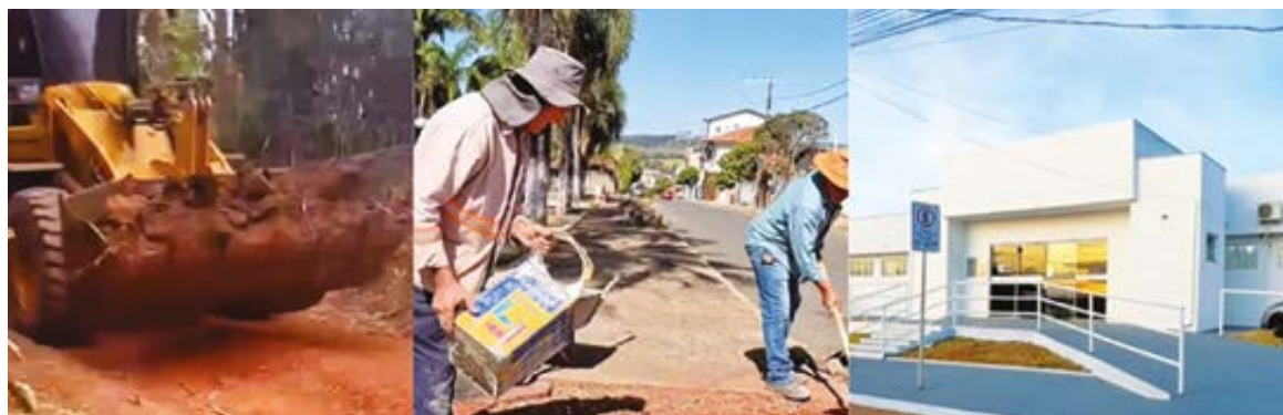
Mais Nerópolis em ação em três frentes: revitalização de estradas vicinais, praça e entrega de UBS revitalizada
