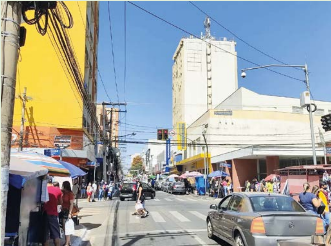
Avenida Engenheiro Portela, que integra o quadrilátero central: previsão do fim do caos da fiação aérea
